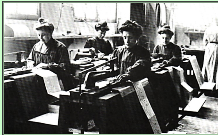
Machines à perforer les cartons pour orgue mécanique
