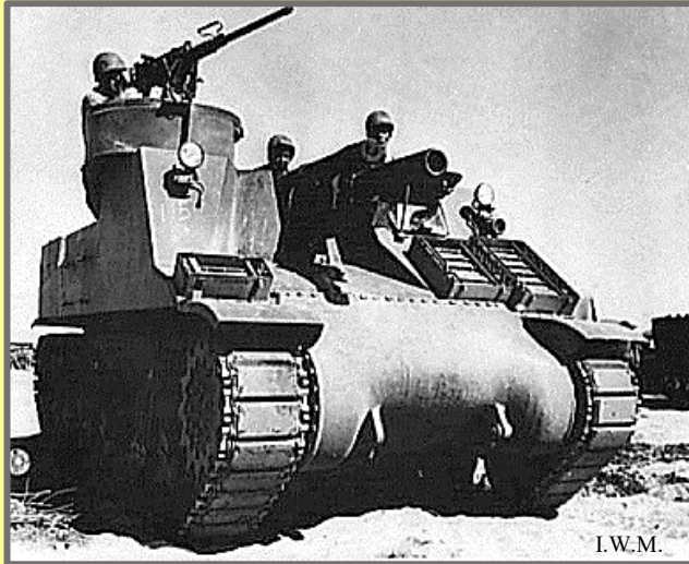
Le canon automoteur M7 105 mm, converti en transporteur de troupes « Kangaroo »
