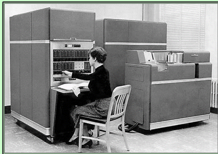
L' IBM 650 - À ses côtés, un lecteur-perforateur de cartes type 533
