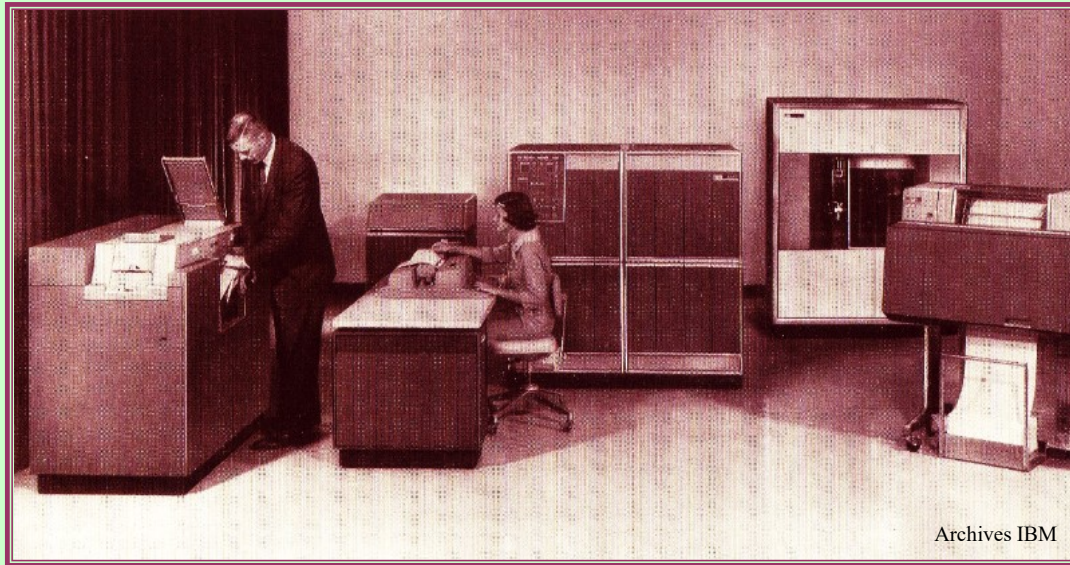
L'IBM 1401 en 1959 : lecteur-perforateur de cartes, console, extension de l'unité centrale, unité centrale, disques et imprimante (ne figurent pas sur ce cliché les armoires de bandes magnétiques que l'on peut toutefois apercevoir au centre du cliché ci-contre).
